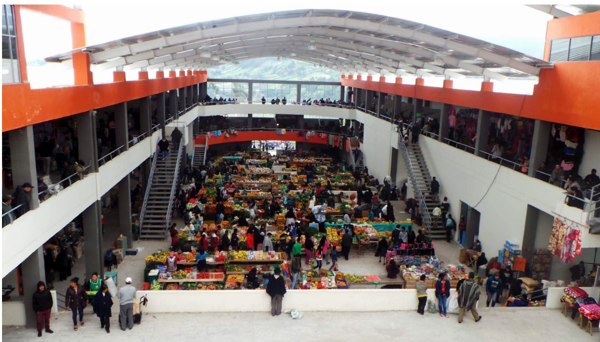
Imagen 1. Vista interna plaza de mercado municipio de Córdoba.
